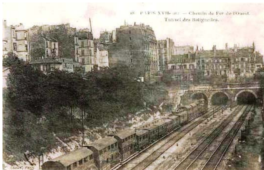
Photographie n°3 : La tranchée des Batignolles dans les années 1850 10
