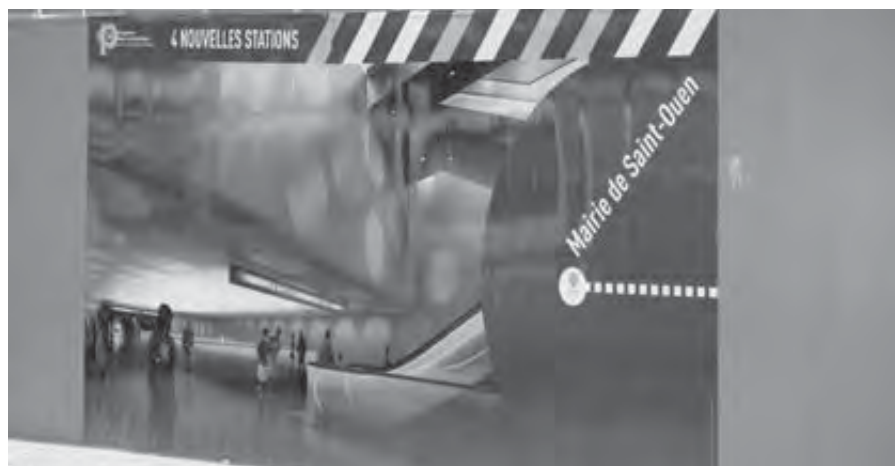
Porte de Clichy, début septembre. Entre les travaux du tramway T3, ceux du prolongement de la ligne M14 et de la Cité Judiciaire, la situation va mettre du temps à s'améliorer. Au préjudice des riverains et des futurs usagers !
