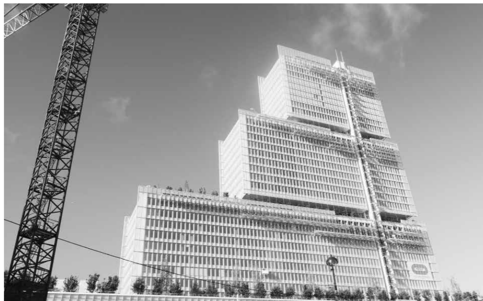
Le bâtiment qui accueillera bientôt le Tribunal de Paris a profondément modifié l'environnement de la porte de Clichy.
